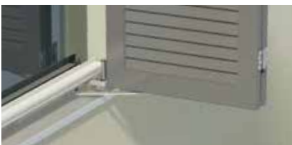
Überdrehsicherung innen
